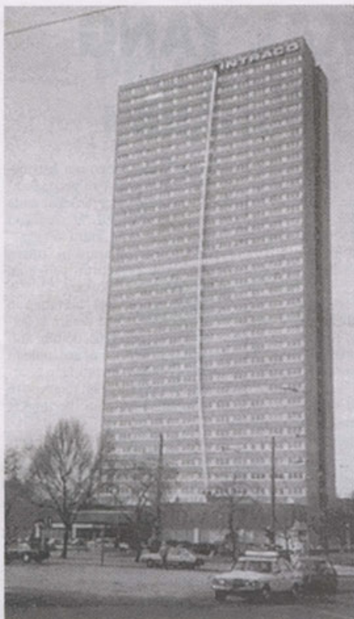
Single entry escape chute : Dalam kondisi darurat, meluncur turun langsung ke tanah dapat menjadi pilihan yang lebih baik daripada tetap berada dalam bangunan.
